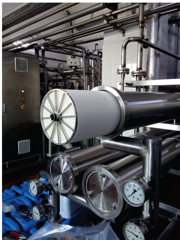
Рисунок 1. Санитарный мембранный элемент SNNF 8038-31 для сгущения сыворожки
